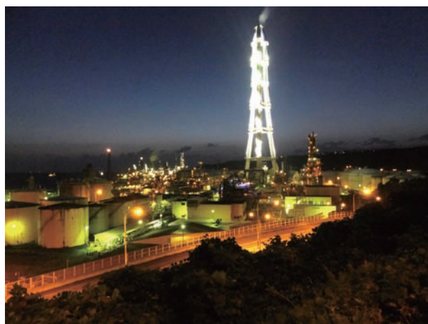
陣屋除雪ステーションからのJXTGエネルギーの工場夜景
